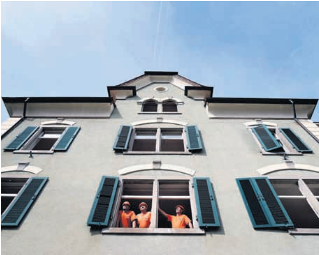
Noch steht das Haus an der Poststrasse 4, gleich neben der Hauptpost. Doch schon in zehn Tagen soll es abgerissen werden.
